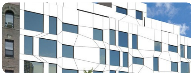
Immeuble neuf de six niveaux, trente-quatre logements.
