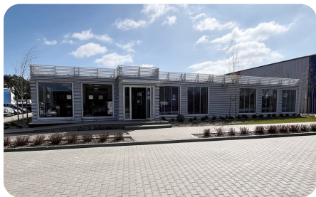
Le bâtiment modulaire traité, en Poméranie occidentale.
