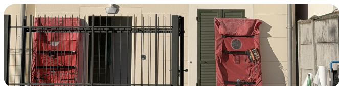
Portes soufflantes en place sur une maison achevée.
