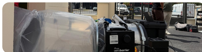
Mise en place de l'équipement AeroBarrier.
