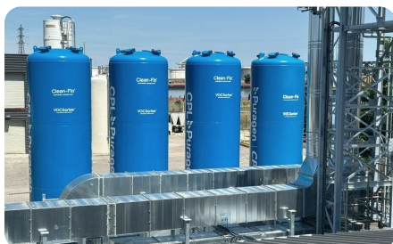
Installations du site industriel.
