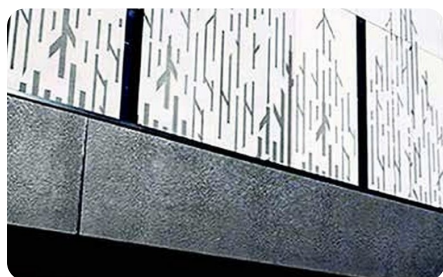
Façade du data center de Fetsund.
