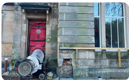
Mise en surpression du bâtiment classé, depuis l'entrée d'origine.
