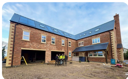
La maison en cours de chantier, avant traitement.
